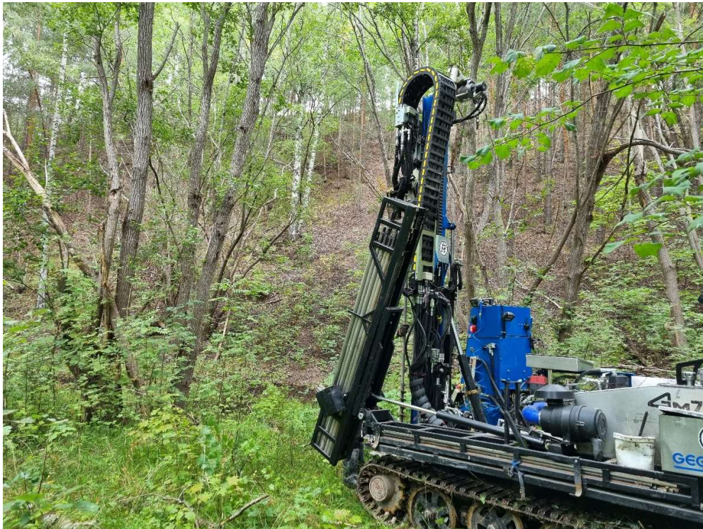
Fotot visar pågående skruvborrning av provpunkt 23AF06 den 25 augusti. Fotot är taget i riktning mot väst.
