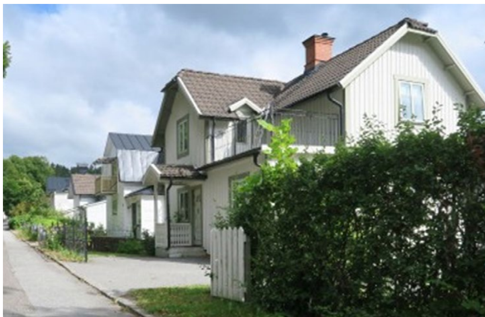
Längs Badstugatan finns en sammanhållen rad med trähus som fått sin prägel under 1920-talet, vilket ses på bilden ovan. Husen har troligen en äldre stomme och har efterhand byggts till. Trots förändringar har byggnaderna utvecklats i en enhetlig stil.
