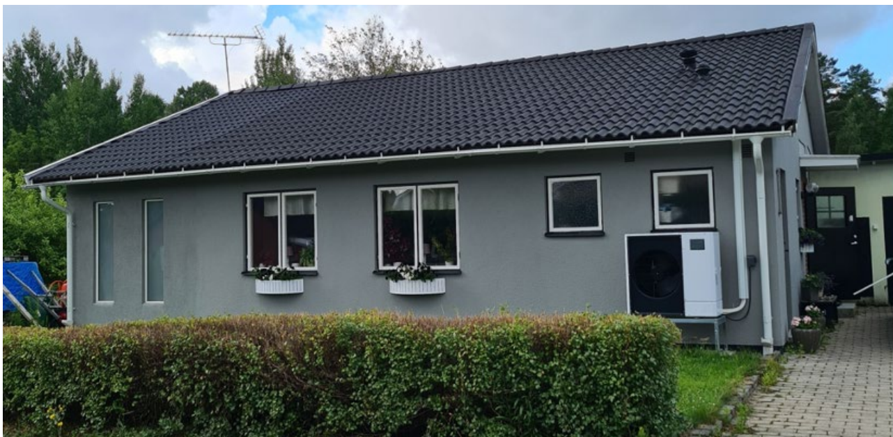
Efter ombyggnation med tillbyggnad
