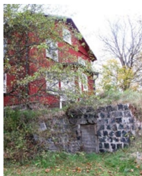
Korpkullen och en jordkällare i sintersten.
