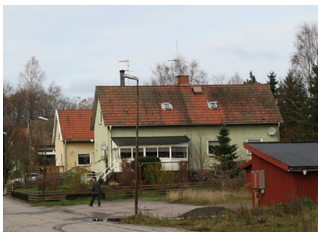
Arbetarbostäder från 1950–52 med putsade fasader i originalkulörerna gult och grönt.
