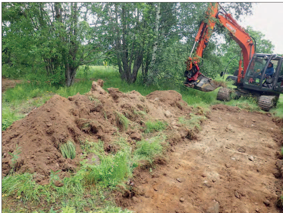
Figur 8. Schaktning i objekt 4 som utgjordes av en övergiven gårdstomt som utflyttades vid laga skifte år 1854. Sandig morän påträffades under grässvålen. Foto från sydväst.
