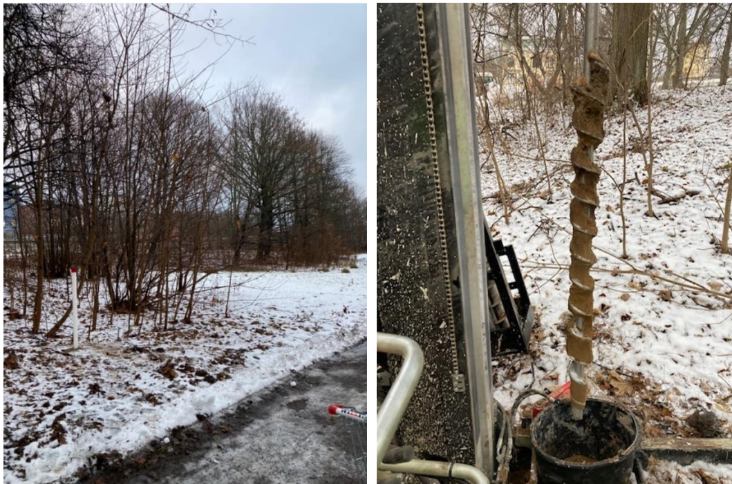
Figur 12, Figur 13. 21AF01GV vid närliggande gång- och cykelväg norr om fastighet Blåhaken 14 och jordlagerföljd ner till 1m.
