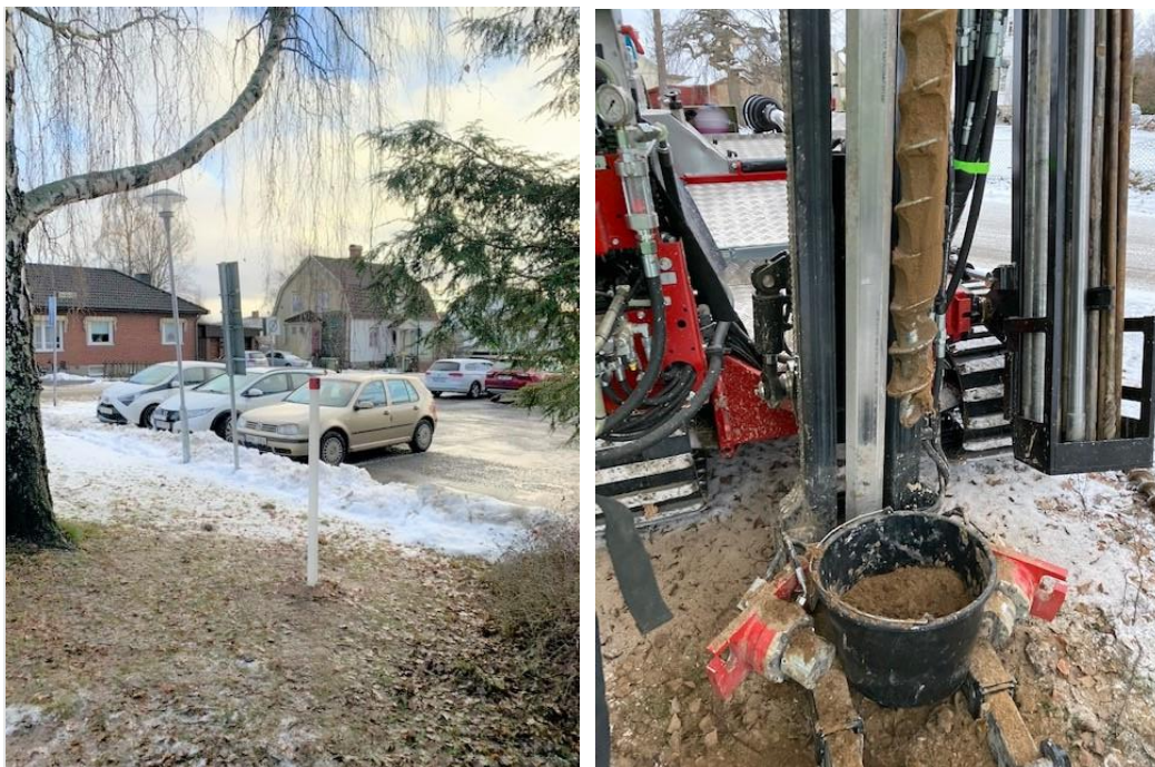
Figur 18, Figur 19. Placering av grundvattenrör 21AF03GV och jordlagerföljd 2.7–3 m.
